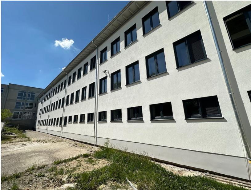
Die Südfassade des Nordtraktes ist fertigverputzt.
