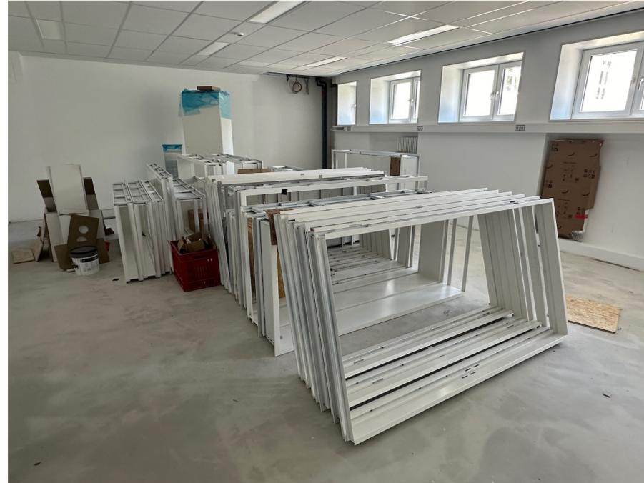
Die Türzargen sind auf aus Stahlblech sind auf die Baustelle geliefert und werden nach Abschluss der Trockenbau- und Fliesen arbeiten eingebaut
