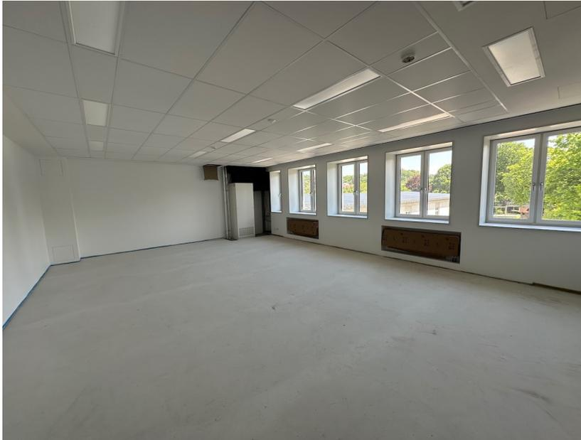
Die Trockenbau- und Malerarbeiten einschl. Elektrofeinmontage im Nordtrakt Bestand sind in den Klassenräumen abgeschlossen. Die Lüftungsgeräte sind bis auf Ebene 1 fertig montiert. Anschließend werden die Lüftungsgeräte vom Schreiner verkleidet.
