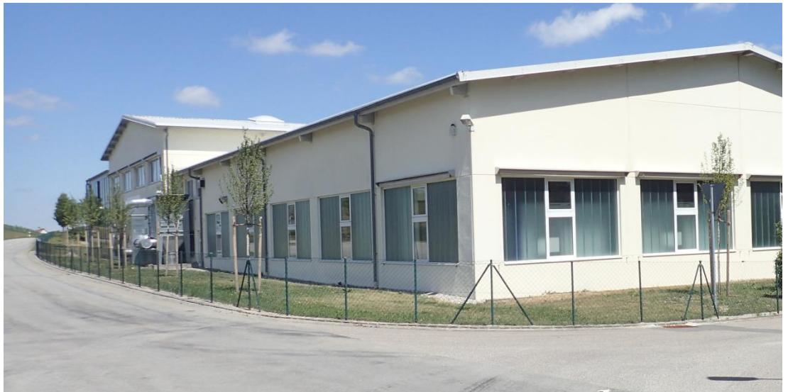
Abb. 6 Bestehendes Gewerbegebiet mit Baumreihe entlang der Straße „Am Sandberg“
